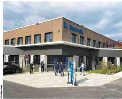
Vue de l'entrée du nouveau site Barcodis à Villedon-sur-Yvette.
